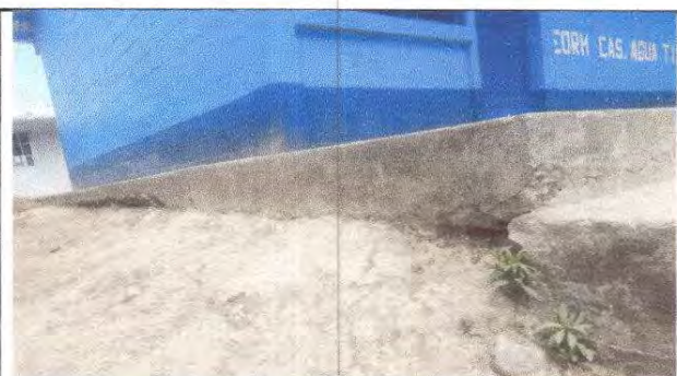
Foto 4: Reparación de banqueta de concreto
