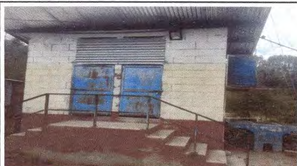
Foto 5: Pintura en muros exteriores e interiores
