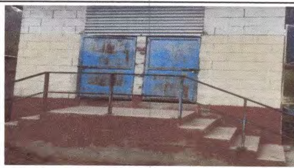
Foto 10: Mantenimiento de barandas de metal
