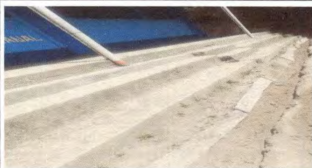
Foto 3: Reparación de cuneta de concreto
