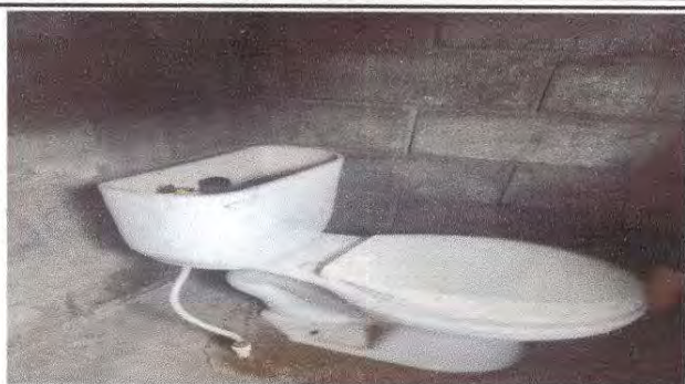
Foto 7: Sustitución de tapadera de sanitario
