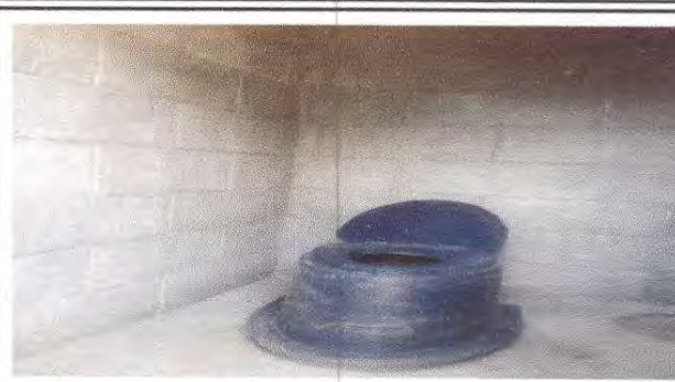
Foto 8: Sustitución de inodoro
