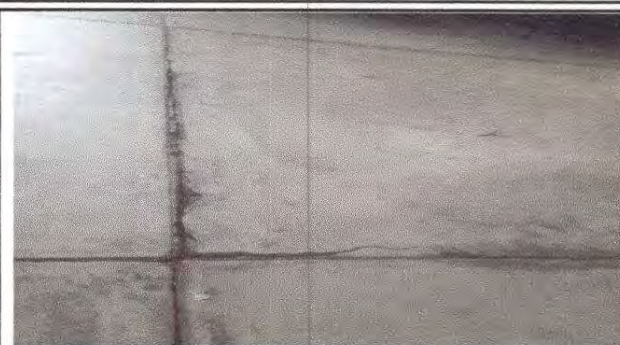
Foto 2: Sustrucción de piso liso por piso cerámico
