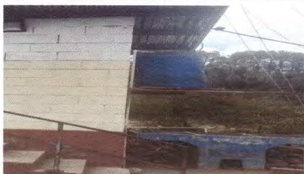
Foto 15: Sustrucción de deposito de Agua
