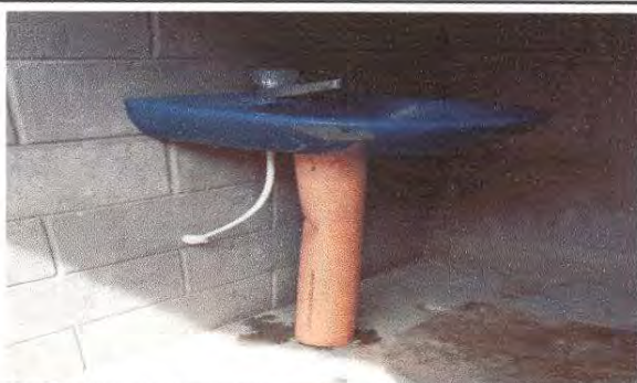
Foto 9: Sustitución de lavamanos
